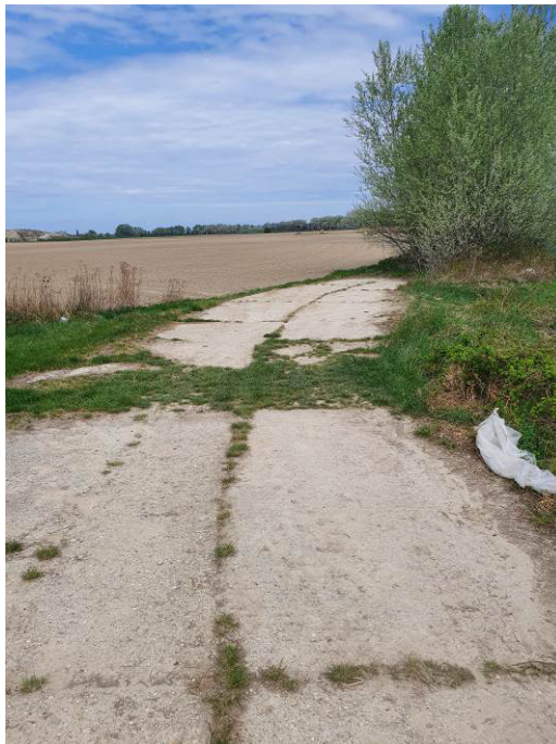
Obr. 9.5: Poľná cesta Pv-3
