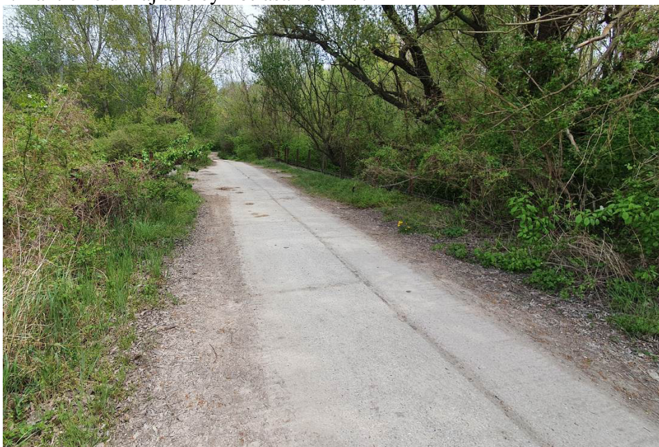
Obr. 9.16: Poľná cesta Pv-11
